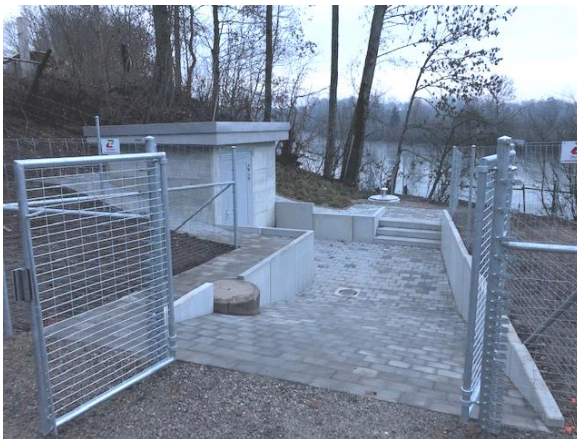
Neues PW Mühle Wolfwil
