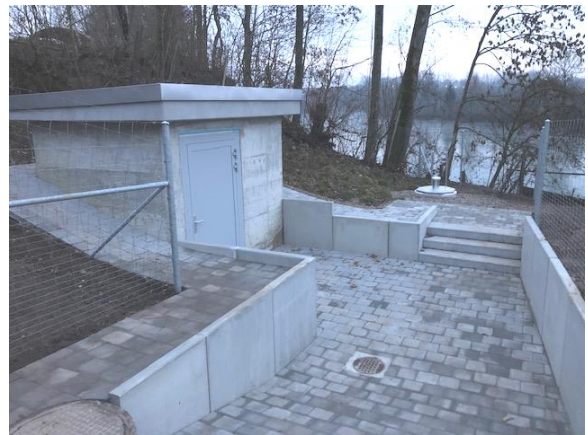
Neues PW Mühle Wolfwil
